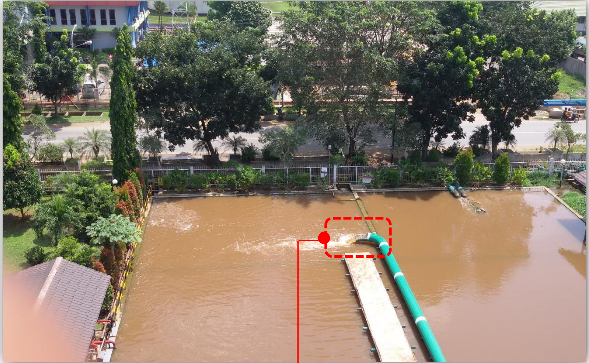
Lokasi Pemasangan PLTMH (Before)
