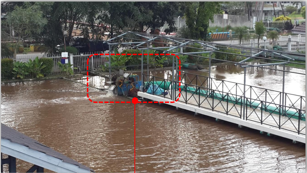
Lokasi Pemasangan PLTMH (After)
