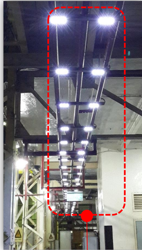
Instalasi Lampu LED Area PLTD Siantan Produksi PLTMH
